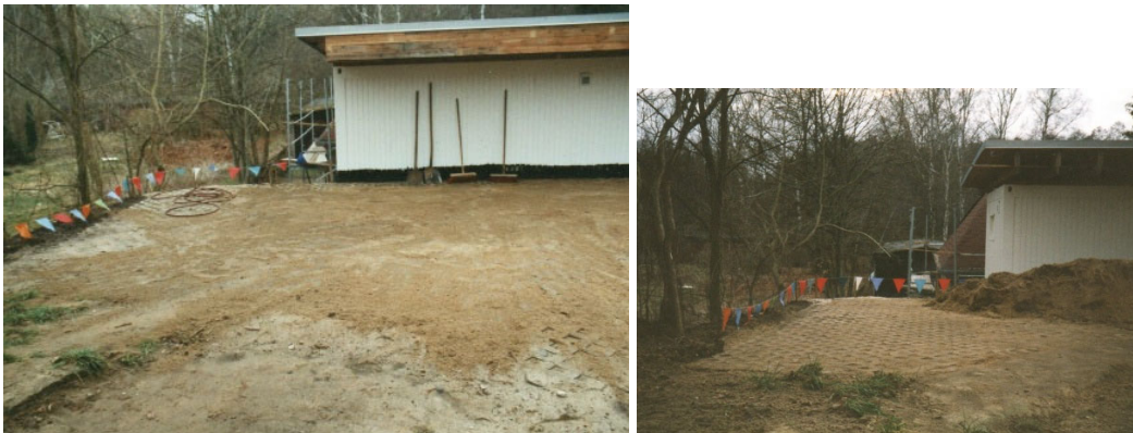
Fotos: Sanitärcontainer und Auffahrt
