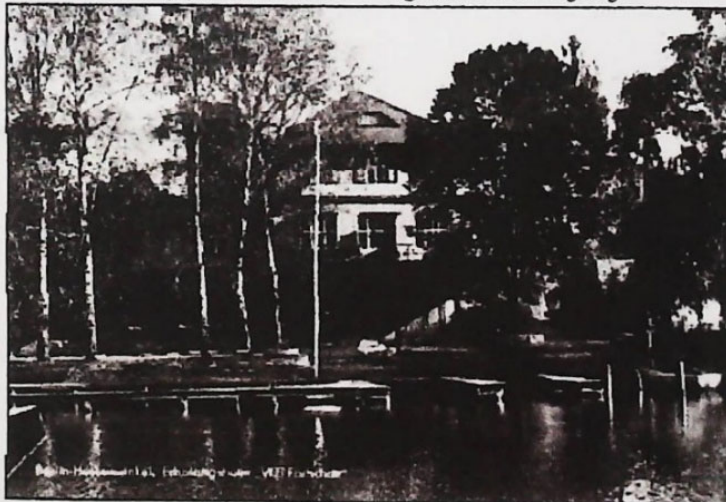
VEB Fortschritt Wasserseite
