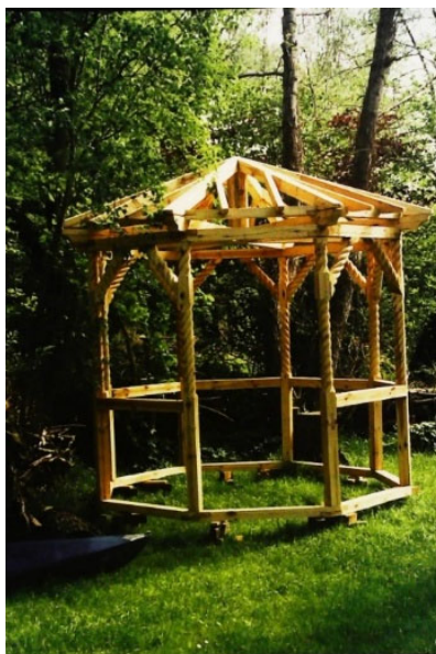
Fotos: Bau des Pavillion
