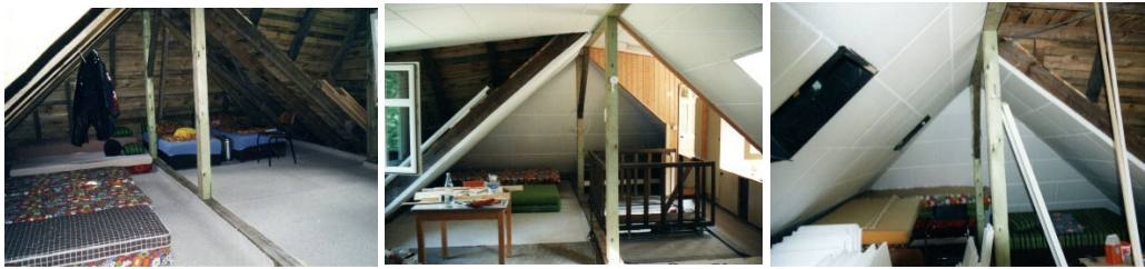
Fotos: Innenausbau des heutigen Vereinshauses
